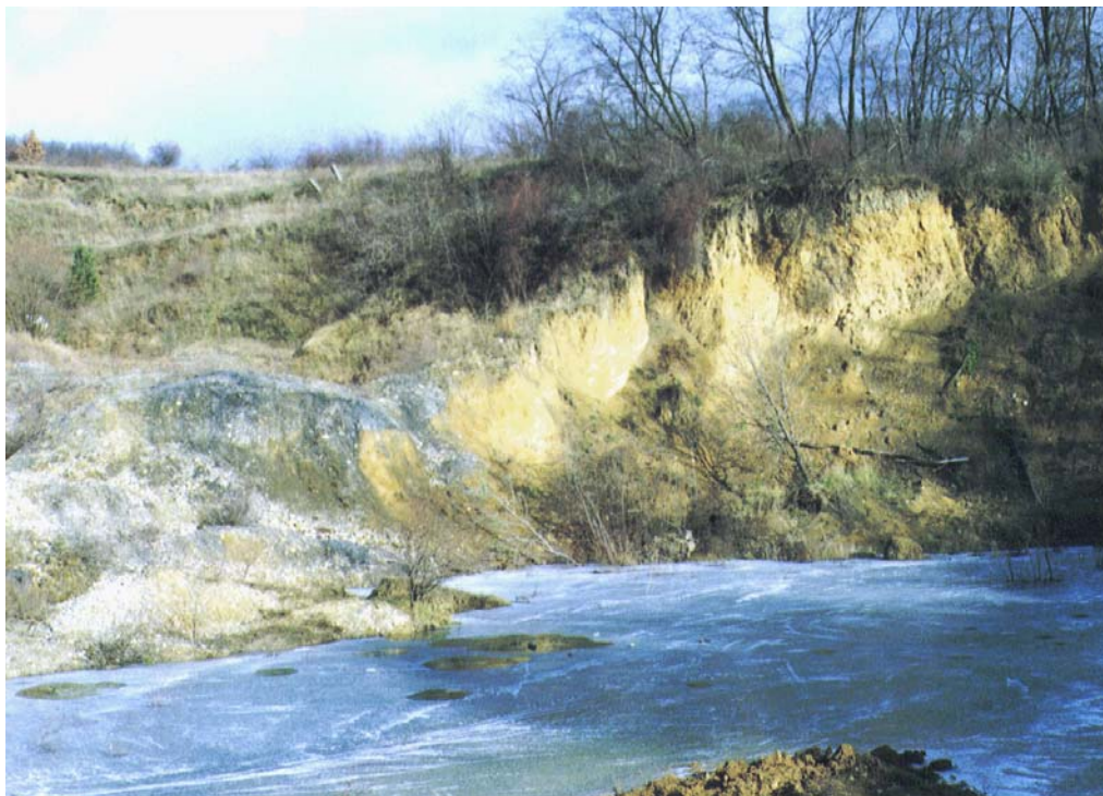
Obr. 1. Poklesová kotlina v závalovom pásme lokality Baňa - Bankov Košice.
