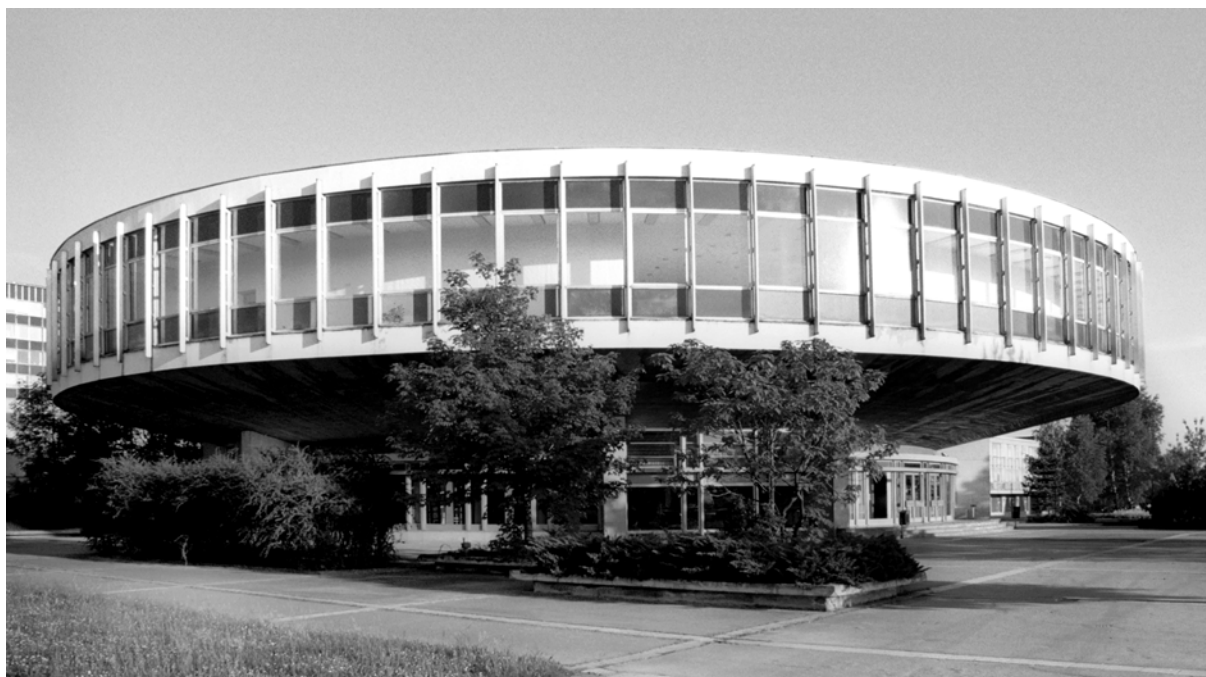
Obr. 1. Pohled na kruhový objekt „C“ areálu VŠB-TU Ostrava
