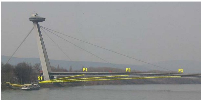
Obr. 4. Umiestnenie stanoviska prístroja a pozorovaných bodov na nosnej konštrukcii Nového mosta cez Dunaj v Bratislave
