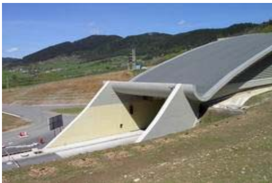
Obr. 2. Západný portál tunela Branisko Fig. 2. West portal of tunnel Branisko
