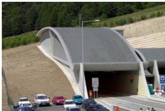
Obr. 3. Východný portál tunela Branisko Fig. 3. East portal of tunnel Branisko
