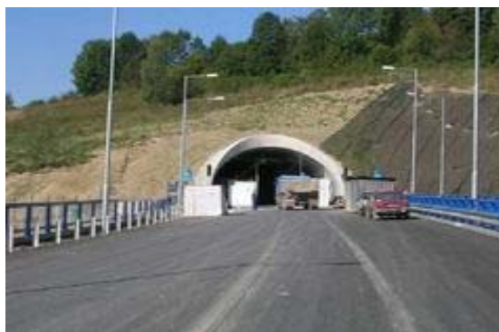
Obr. 5. Východný portál tunela Fig. 5. East portal of tunnel
