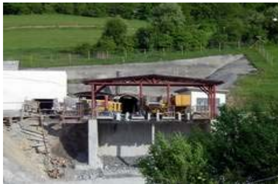
Obr. 11. Západný portál tunela Fig. 11. West portal of the tunnel
