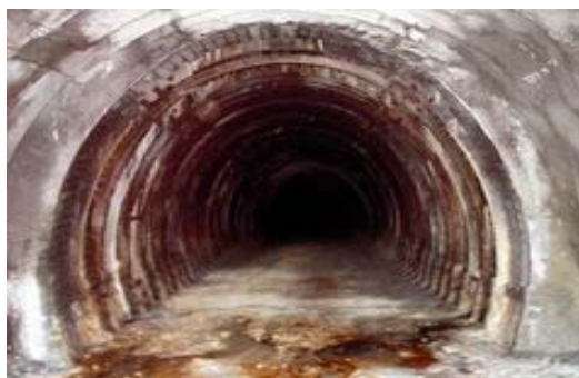
Obr. 7. Prieskumná štôľňa tunela Fig. 7. Searching of tunnel
