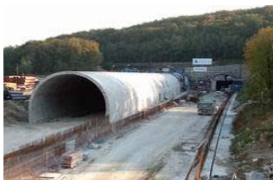
Obr. 8. Severozápadný portál tunela Fig. 8. North-west portal of tunnel
