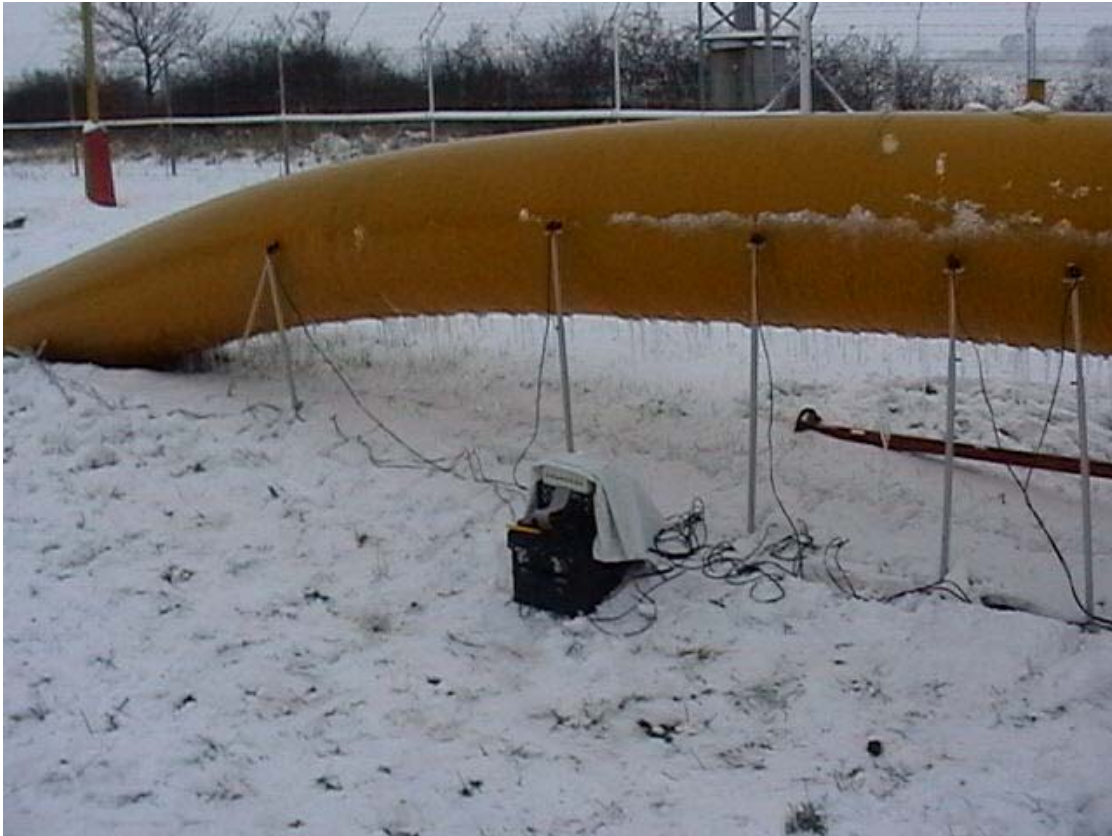
Obr. 5. Pohľad na signalizačné zariadenie počas prototypových skúšok čistiaceho behu plynovodu DN 700 Ruská – Behynce. Fig. 5. View on the signalling equipment during prototype tests of the cleaning process on the pipeline DN 700 Ruská – Behynce.
