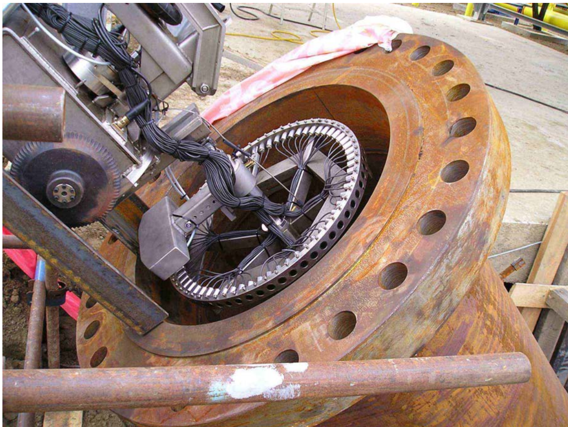
Obr. 2. Čelo zariadenia PIT vchádzajúceho do vstupnej príruby diagnostikovaného kolektora Fig. 2. Head of the PIT device entering the inlet flange of the inspected collector line
