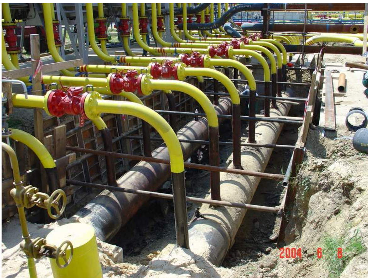
Obr. 1. Pohľad na výkopy kolektorov K 102, K 103
