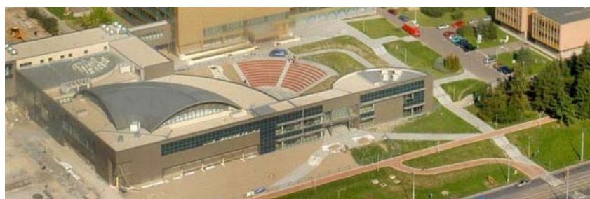
Obr. 5. Nová aula VŠB-TU Ostrava a Centrum informativních technologií. Fig. 5. New VSB-TU Ostrava university hall and Informative Technologies Centre.
