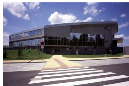
Obr. 4. Sportovní hala v Opavě. Fig. 4. Sports hall in Opava.
