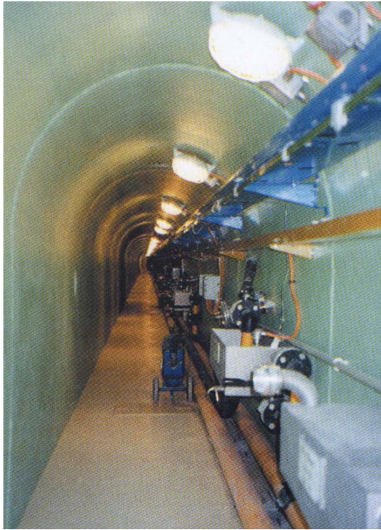
Obr. 4. Pohľad do kontrolnej a revíznej štólne. Fig. 4. View on the control and inspection gallery.
