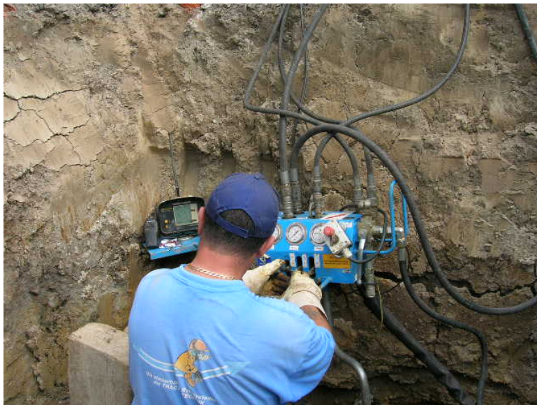
Abb. 10. Steuerung der GRUNDOPIT-Bohranlage (Stuttgart-Vaihingen, Sommer 2006). Fig. 10. Steering of the Grundopit drilling system.
