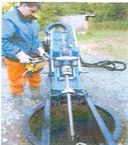
Abb. 17. Bohranlage auf Drehkratz in Arbeitsposition Fig. 17. Drill equipment turns behind the work
