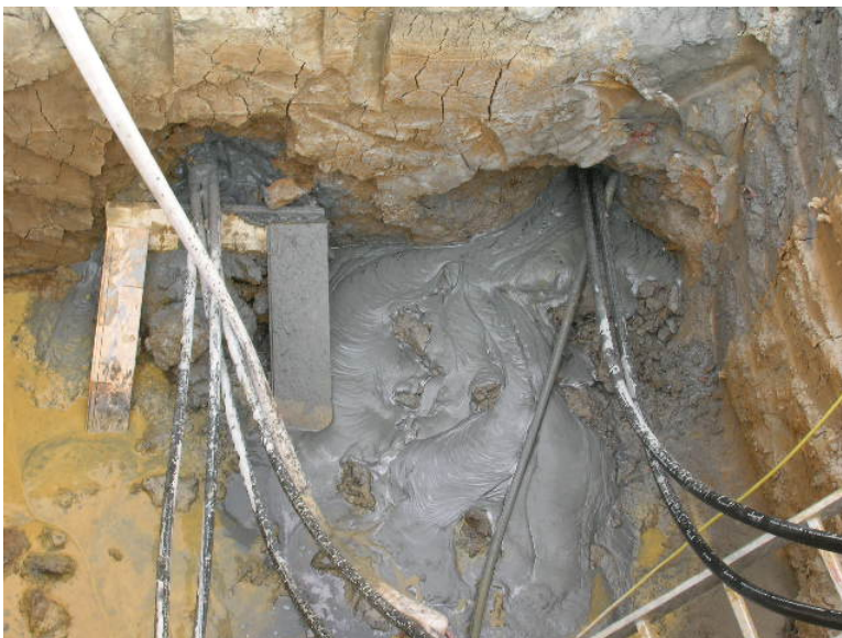
Abb. 13. In die inzwischen erstellte zweite, parallele Horizontalbohrung wurde eine U-Sonde eingezogen. Im Rückwärtsgang wird das Bohrloch mit einem graphithaltigen Thermodämmverfüllt. Fig. 13. Two sorts of installed geothermal sonds, parallel at a distance of 1 meter, embedded in a geothermal filling material.
