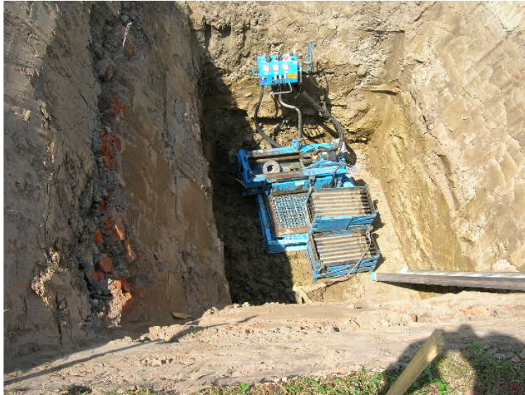
Abb. 9. GRUNDOPIT-Bohrgerät in der 3,50 m tiefen Startgrube im Testgelände Stuttgart-Vaihingen (MPA, Universität Stuttgart) Fig. 9. Grundopit drilling system in a 3,50 m deep start pit.
