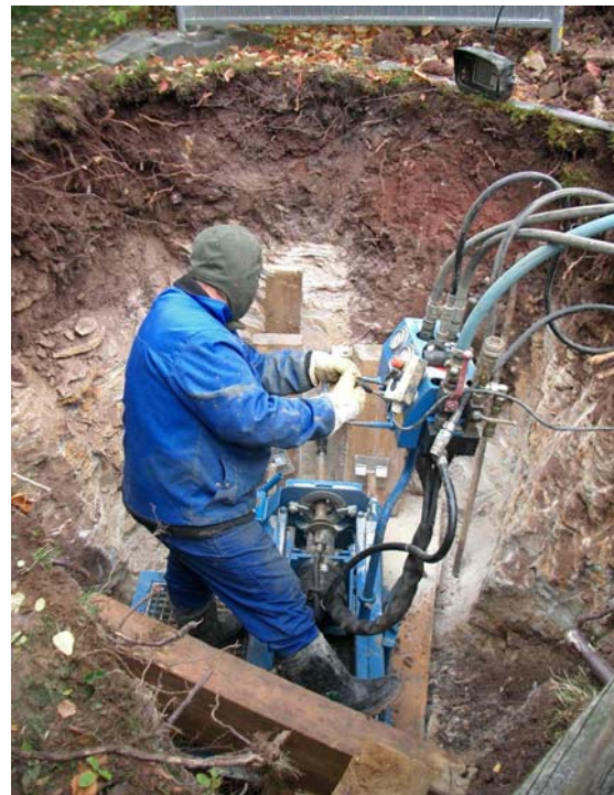
Abb. 5. Auch Felsbohren ist mit der GRUNDOPIT-Kleinbohranlagemöglich. Hier eine Bohrung im Buntsandstein des Nord-Schwarzwaldes
