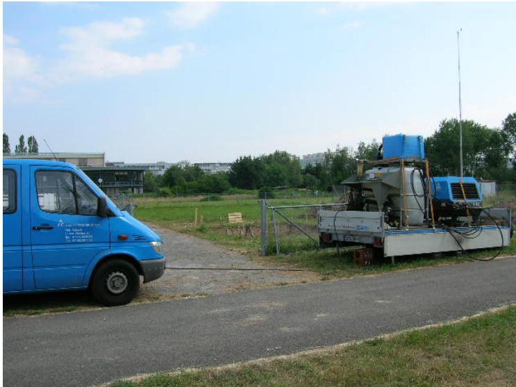
Abb. 15. Das ganze Bohrequipment (Mischanlage, Hydraulikstation, Bohrerät) der GRUNDOPIT-Anlage passt auf einen Kleintransporter samt Anhänger. Fig. 15. Complete mobile Grundopit drilling unit with the mixing station, pneumatic power station and a small transporter.
