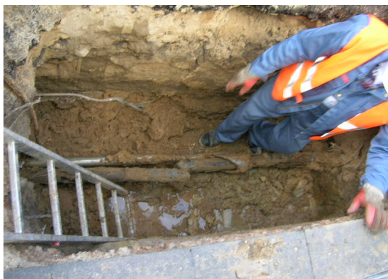
Abb. 8. Umfädeln des Bohrkopfes auf einen neuen Überbohrabschnitt.
