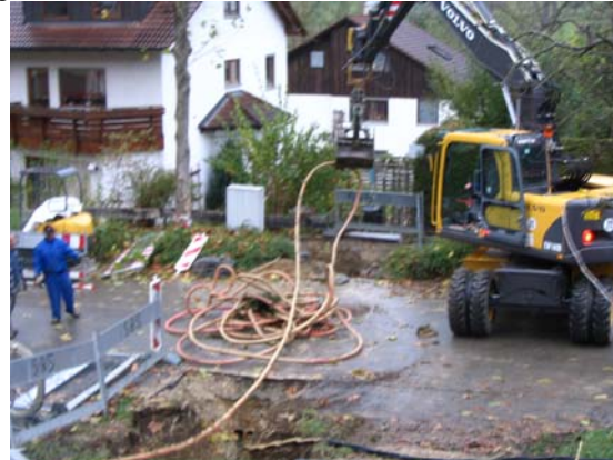
Abb. 4. Das überbohrte und vom Erdreich gelöste Altkabel wird gezogen. Fig. 4. The old loosened cable gets tracked out and rolled for the recycling transport
