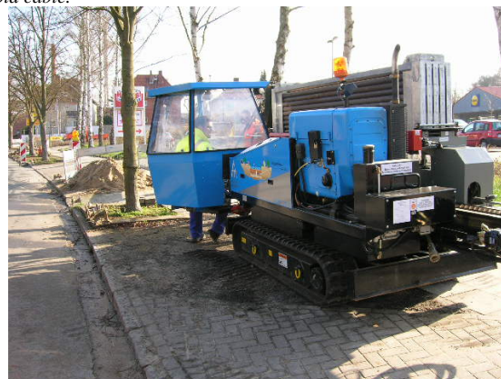
Abb. 7. Grundodrill 13 X beim Überbohren eines 60 kV-Kabels. Fig. 7. Drilling equipment 13 X in boring for 60 kV electric cables.
