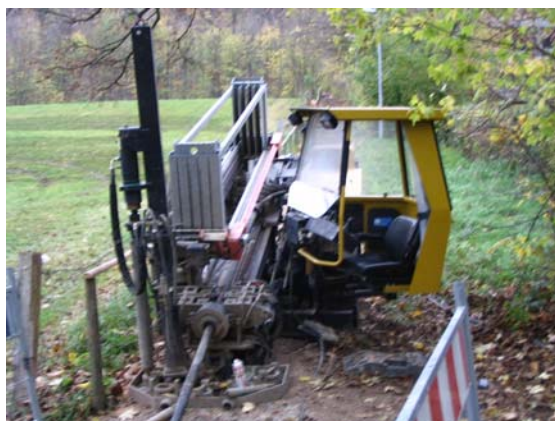
Abb. 1. Startpunkt der Kabelaustauschtrasse in Dettingen/Erms Gebohrt wurde mit einem Grundodrill 13 X. Fig. 1. Start place of the cable exchange trace in Dettingen/Erms SW-Germany.
