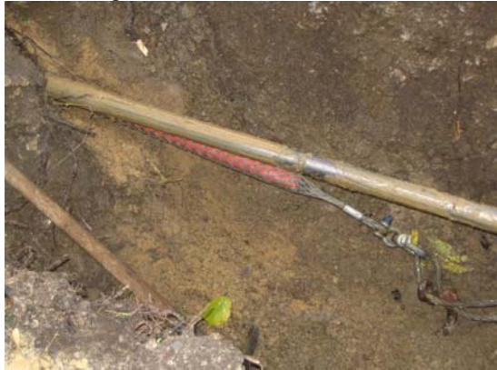
Abb. 3. Der Überbohrkopf überfährt den Beginn des zweiten Altkabelabschnittes. Fig. 3. The wash over drill head starts the second exchange section
