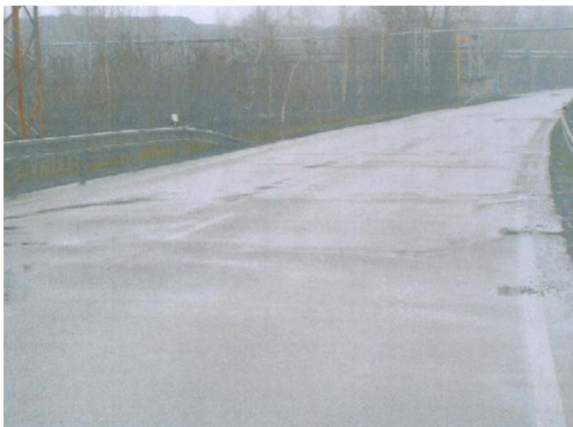
Obr. 6. Zvlnění povrchu komunikace. Fig. 6. Waviness of the road surface.
