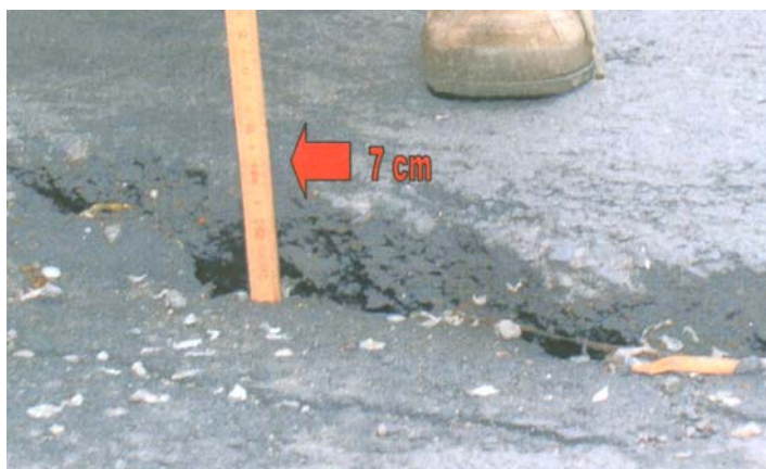
Obr. 6. Zvlnění povrchu komunikace. Fig. 6. Waviness of the road surface.
