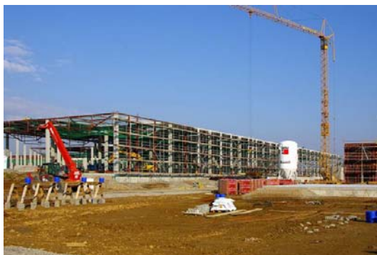
Obr. 6. Výstavba GFT. Fig. 6. Building-up of GFT.
