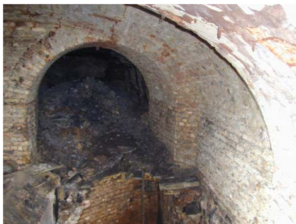
Obr. 23. Hlubinný zásobník dolu Ludmila – úroveň horních chodeb (severní část). Fig. 23. The sublevel bin of Ludmila Mine – the upper corridors level (Northern part).
