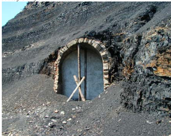
Obr. 19. Vodní chodba u hlavních čerpadel po zadržím HBZS, (28. 6. 2005).
