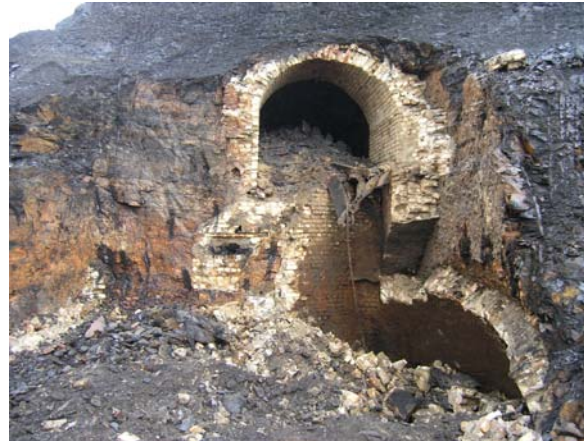
Obr. 26. Hlubinný zásobník dolu Ludmila – po částečném odtěžení horních chodeb. Fig. 26. The sublevel bin of Ludmila Mine – after partial removal of upper corridors.
