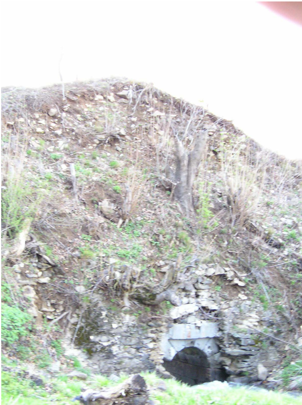
Obr. 4. Pohľad na návodný svah porušenej kamennej murovanej priehrady s čelom dnového výpustu, v Zlatej Bani (máj 2005). Fig. 4. View on the wet slope of the broken dam built from a rock with the brow of bottom outlet in Zlatá Baňa (May 2005).
