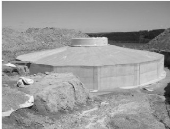
Fig. 1. Foundation of the WT Loděnice – Lipina (adopted from: http://www.vehl.cz/?lang=cz&cat=3&article=19 ).
